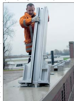
Passgenauer Sitz der Stütze durch Einrasten.
