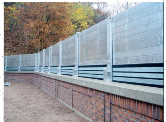
Dammbalken aus Stahl, feuerverzinkt bis HQ 100.
