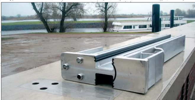
Zentrierzapfen am Stützenfuß.
